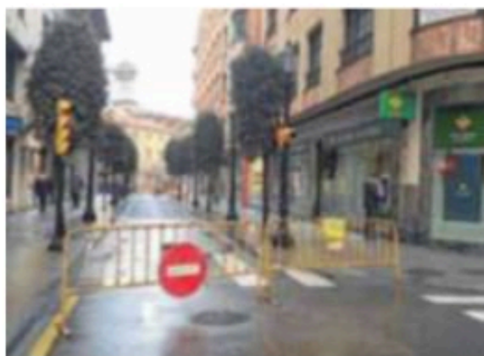
Tramo cortado al tráfico en el cruce con Cabrales.
